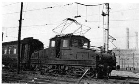
Fig. 268. — 1932-33. Ancienne locomotive à 600 V, type BB, série 1 à 8 transformée pour fonctionnement sous 1500 V avec équipement métadyne (Paris). (Photo Vilain)
